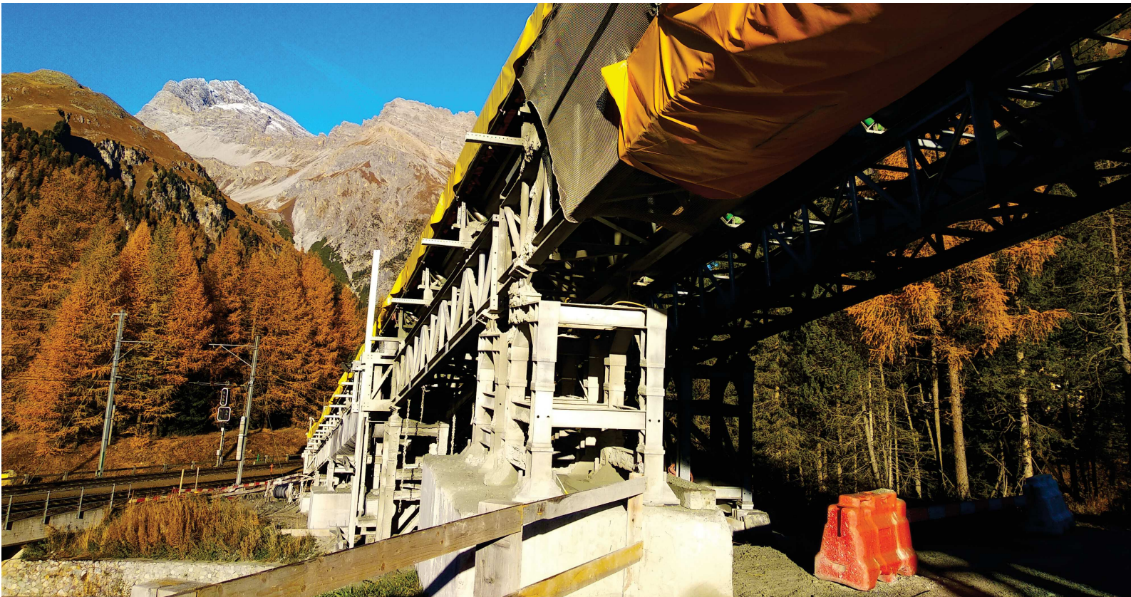
Neubau Albulatunnel, Preda (Schweiz)
